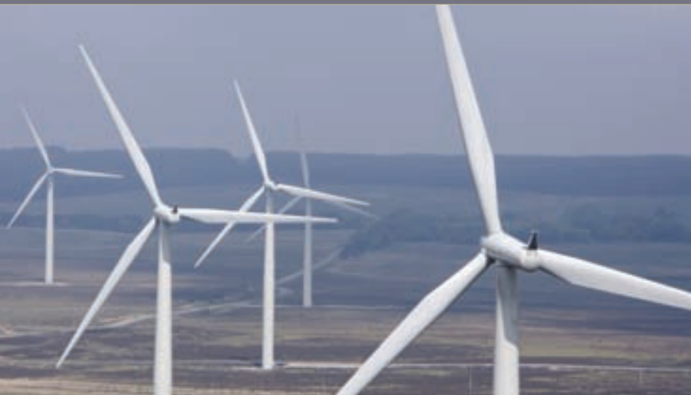
SIEMENS ENERGY INC. (2)
